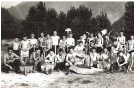
Gradnja kegljišča v Hrastniku leta 1960
