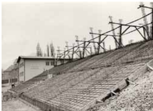
Gradnja tribun na stadionu Rudar Trbovlje.
