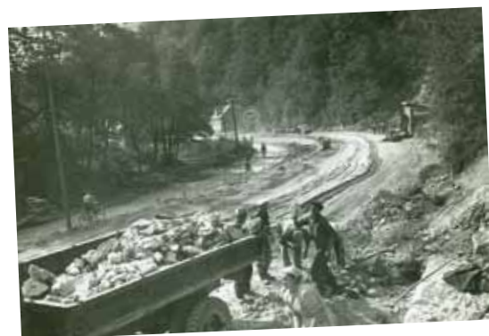
Gradnja ceste skozi Trbovlje
