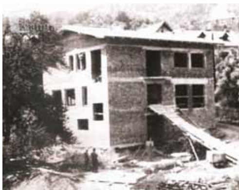
Gradnja godbenega doma v Hrastniku leta 1953.
